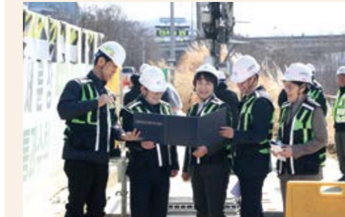
탄천변 동측도로 구조개선사업(1구간) 건설 공사 현장방문
